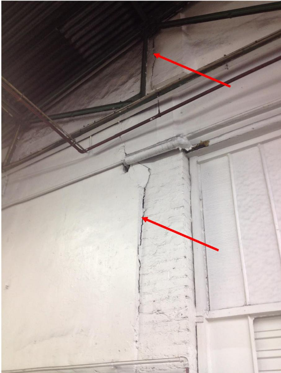
Fissuration du mur en rez-de-chaussée
