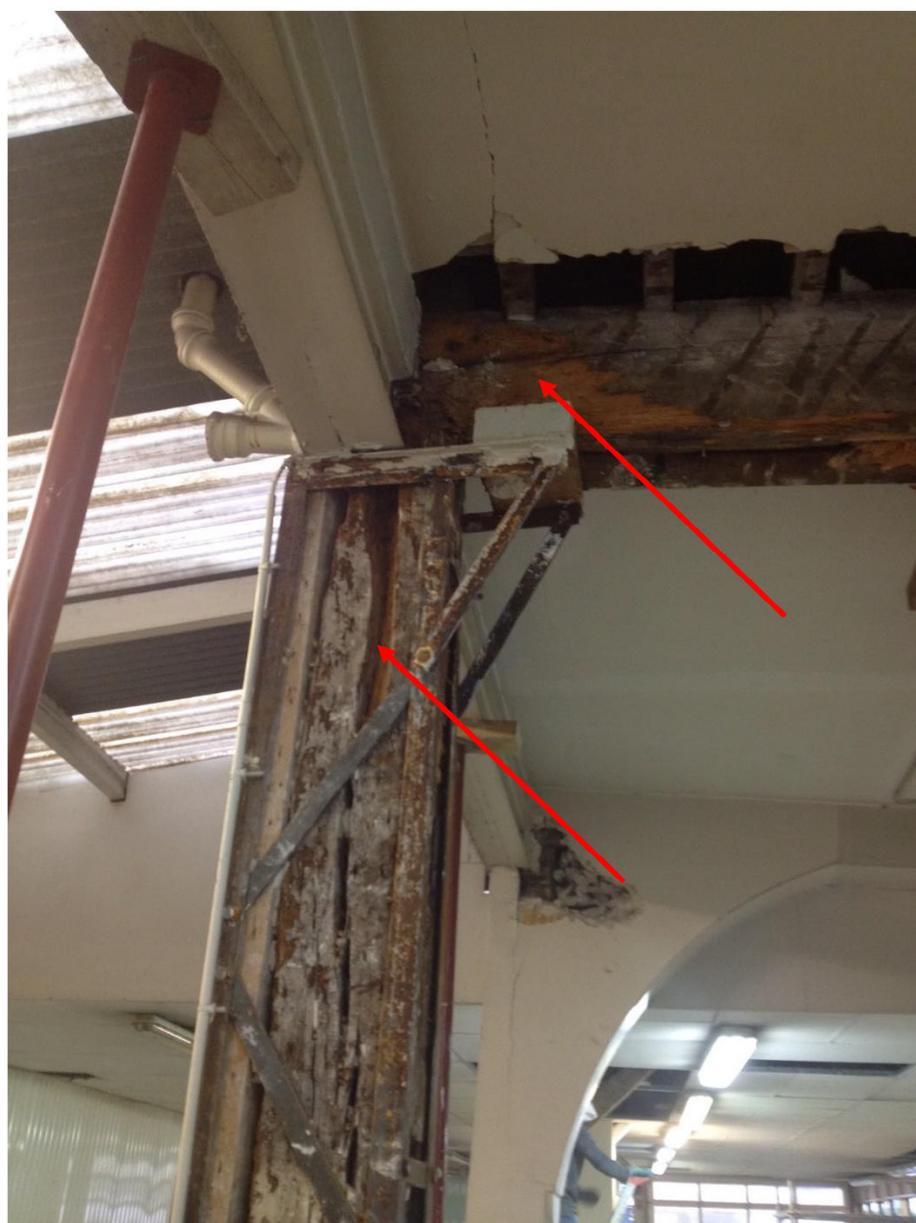
Détail d'un poteau bois renforcé par une ancienne structure métallique et
